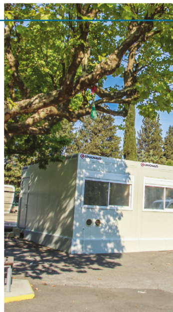
CI-DESSUS : NOUVELLE CLASSE EN STRUCTURE MODULAIRE.
